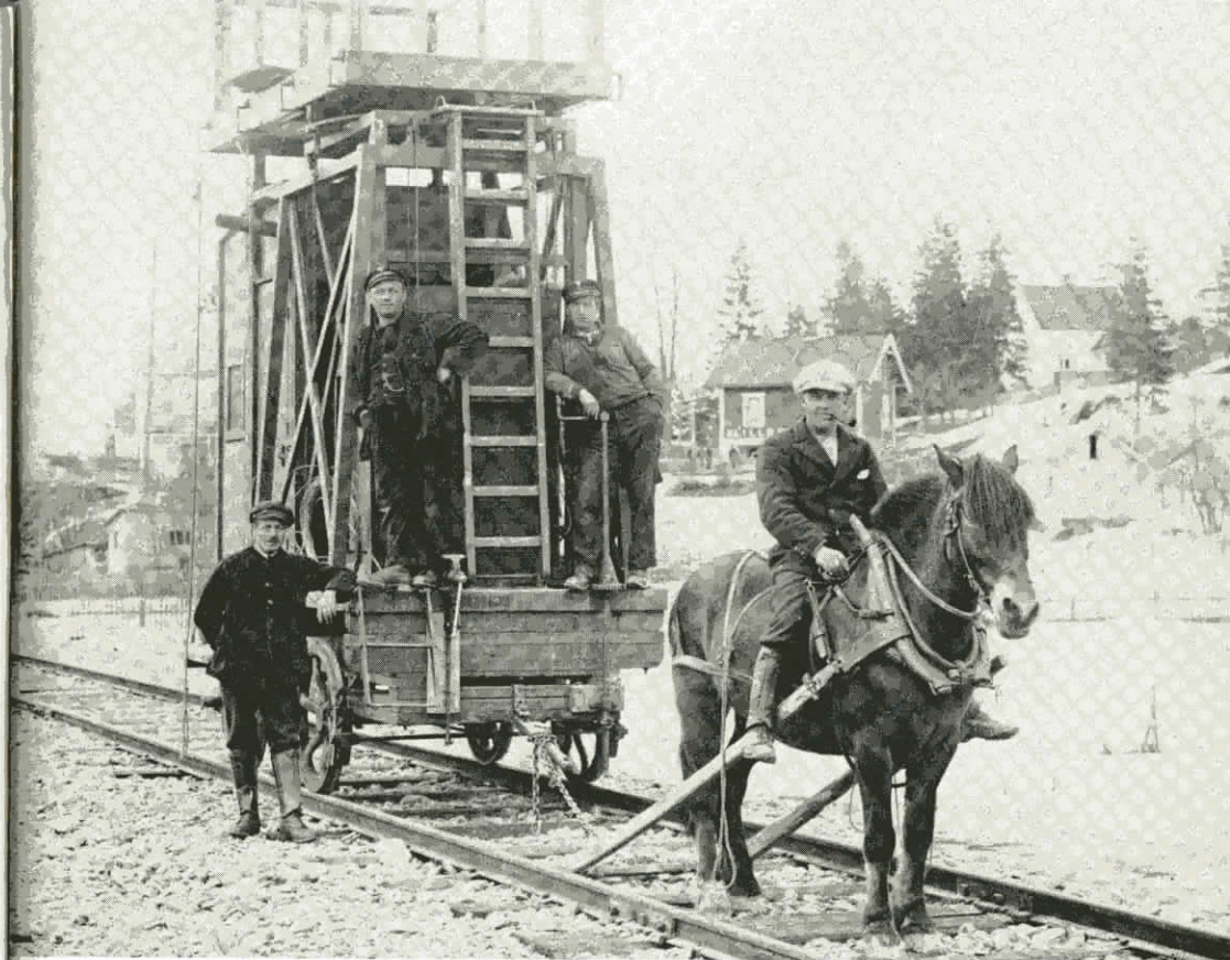
Fra anleggstiden av Bærumsbanen, der hesten hjelper til med å gjøre seg selv overflødig mens skinnegangen arbeider seg fremover mot Avløs.
